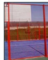
7. Malla electro soldada galvanizada y lacada al horno de 50x50x4 mm y de dimensiones 995x1992(±2).
