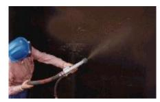
Sobre la imprimación seca, proyectar el mortero con máquina neumática de proyección (Tipo PFT N 2 V FU 400) o manualmente con "escobillón", con un rendimiento aproximado de unos 4,0 kg/m² (en función de la rugosidad del soporte).
